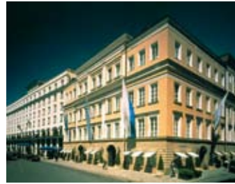
Bei der Umstellung der Fernwärmeleitung im Hotel Bayerischer Hof von Dampf auf Heißwasser ...
