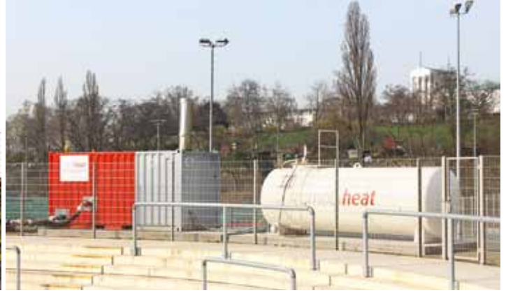
Beim 2.-Ligisten FSV Frankfurt übernahm ein Heizcontainer mit 1 MW Leistung die Rasenheizung. Der 10000 l fassende Heizölbehälter stand neben der Fankurve.
