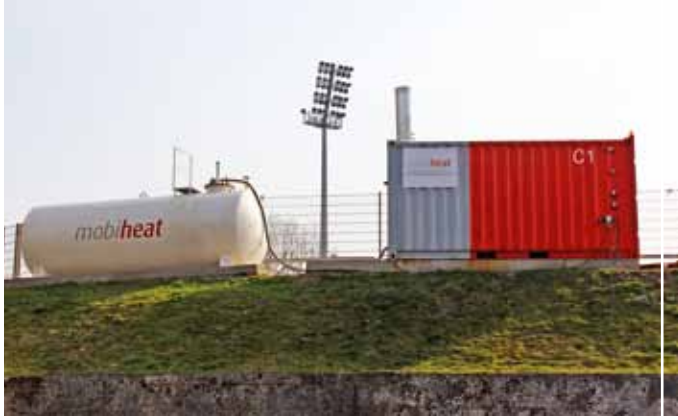
Beim 2.-Ligisten FSV Frankfurt übernahm ein Heizcontainer mit 1 MW Leistung die Rasenheizung. Der 10000 l fassende Heizölbehälter stand neben der Fankurve.
